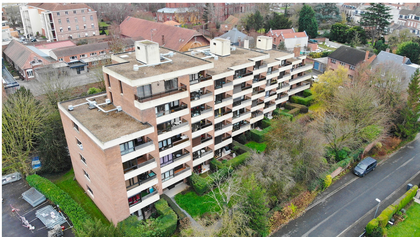
— Etat initial de la résidence
