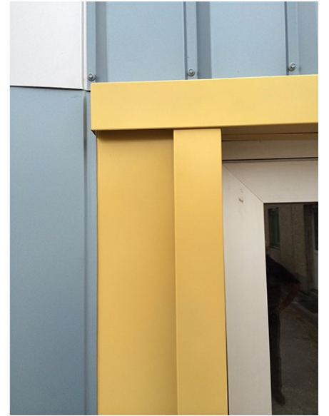
— Détail de façade
