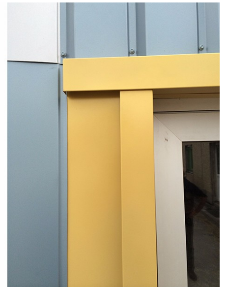
— Détail de façade
